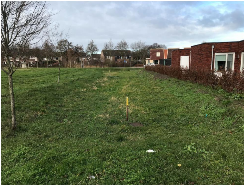
Figuur 3: Voorbeeld wadi, retentievoorziening Hasselt
